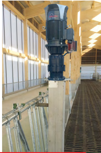
Erhöhte Montage auf Konsole im Laufstall
