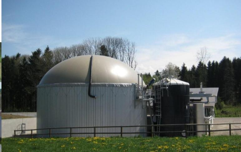
Abdeckung mit Doppelmembrandach zur Einbindung in eine Biogasanlage
