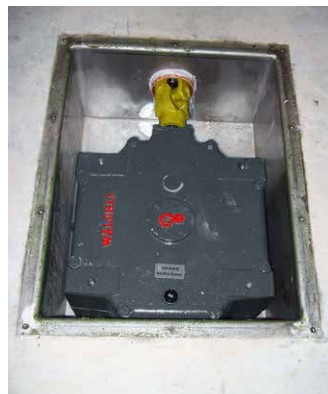
Exécution sous dalle avec entraînement de côté
