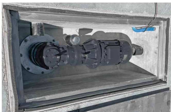
Exécution encastrée, entraînement avec engrenage angulaire et moteur
