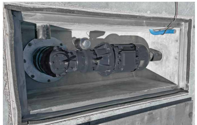
Versenkte Ausführung, Antrieb mit Winkelgetriebe und Motor
