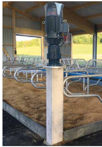
Antrieb direkt auf der Grubendecke
