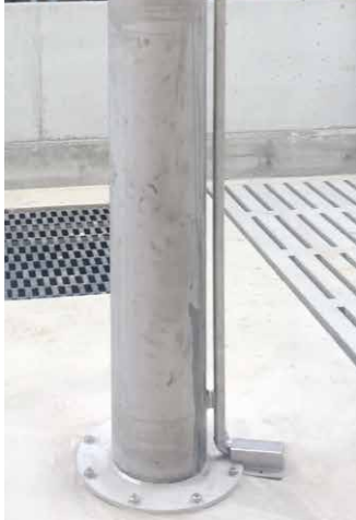
Erhöhte Montage auf Konsole im Laufstall
