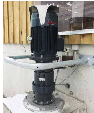
Antrieb direkt auf der Grubendecke
