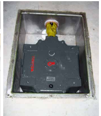
Versenkte Ausführung mit Seitenantrieb
