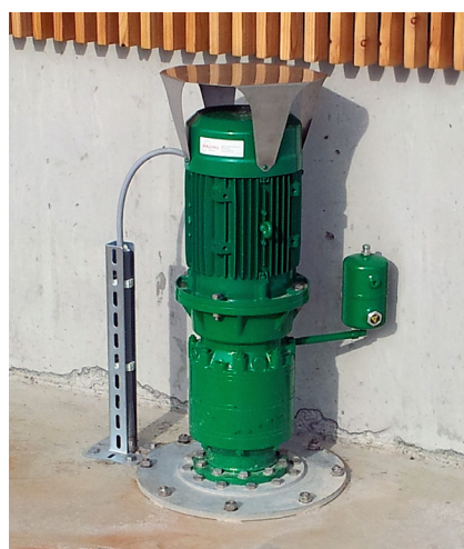
Antrieb direkt auf der Grubendecke
